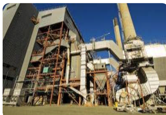
Centrale thermique Callide convertie à l'oxycombustion
