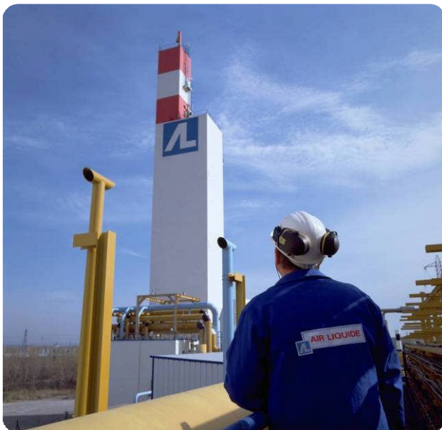
Unité de Séparation des gaz de l'Air (ASU)
