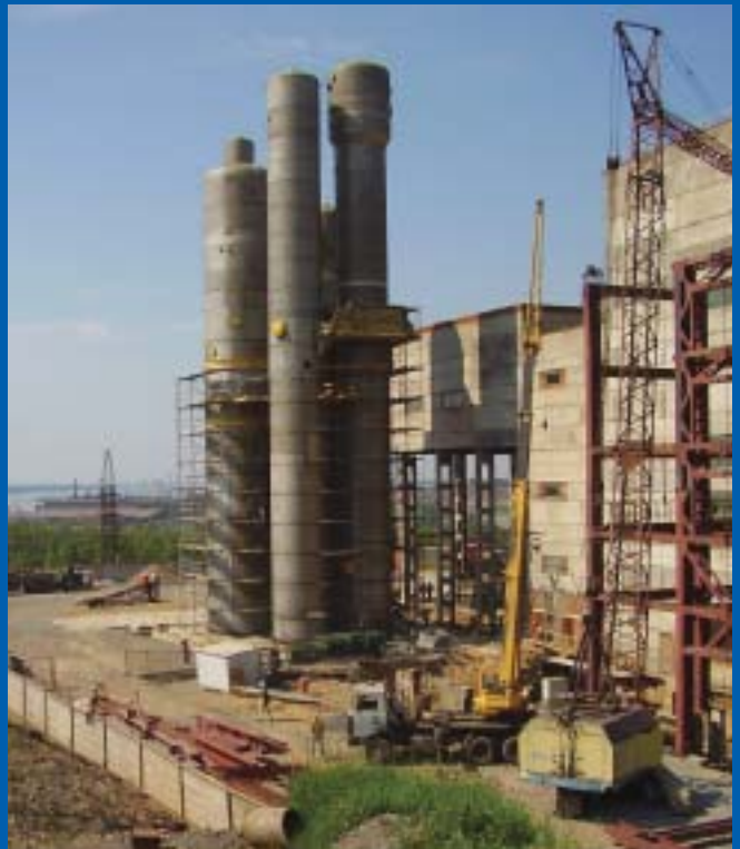
Construction de la plus grande ASU de Russie à Cherepovets.
