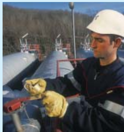
Unité de purification et de liquéfaction de dioxyde de carbone
