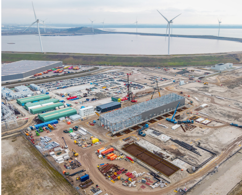
● Chantier de l'électrolyseur ELYgator, à Maasvlakte, aux Pays-Bas.
